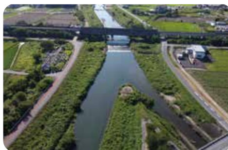
令和5年8月 着工前
