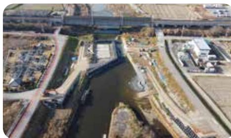
令和5年12月 右岸エプロン撤去完了・2次縮切完了
