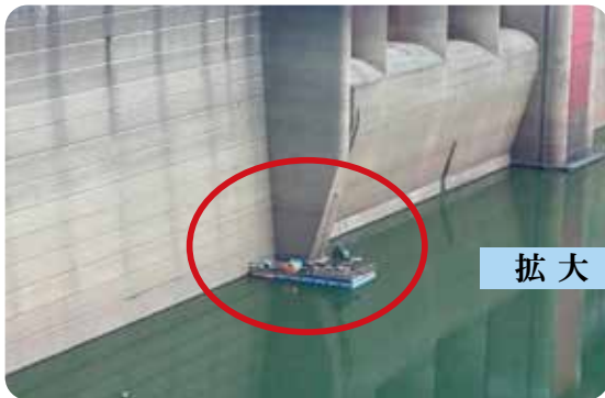
調査状況写真 (下流部)
