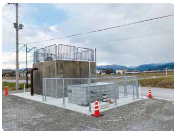
揚水機 施工状況 (目加田) 電気関係のみ未完了
