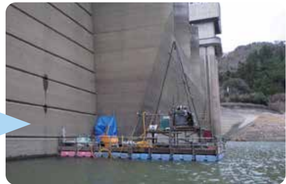
作業台船を使用した調査状況 (下流部)
