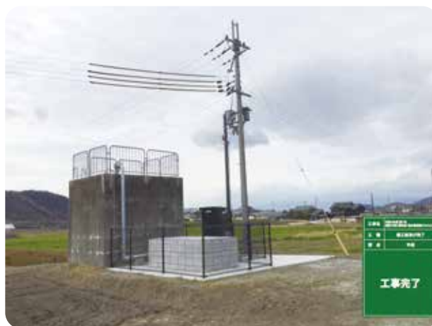
工事完了 (平田町)
