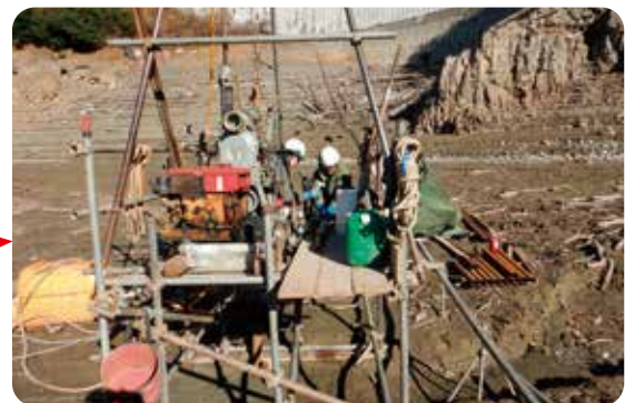
調査状況写真 (中流部)
