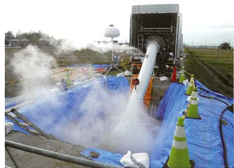
管更生施工状況
