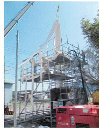
管更生施工状況
