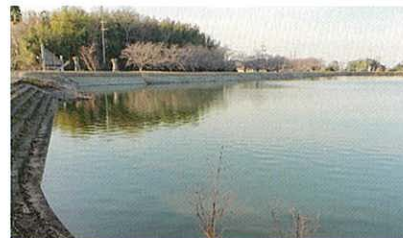
重要水防構造物（ため池） 有事に備えた定期的な点検の実施
