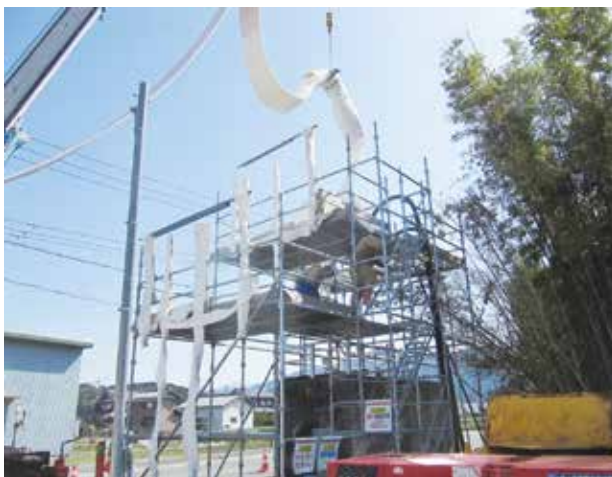
(参考) 右岸 (軽野・蚊野) 支線水路第9工事
