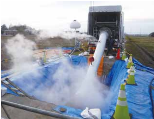
(参考) 右岸 (軽野) 支線水路第8工事
