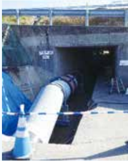
愛知第1幹線水路
